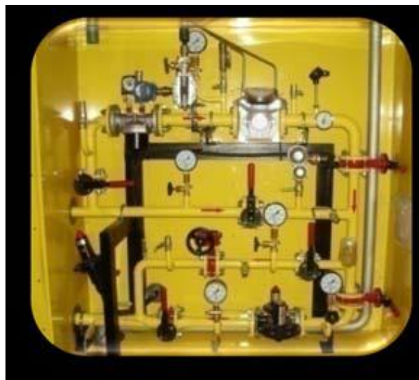
Рисунок 5 – Внешний вид и расположение оборудования в ШРП «ИТГАЗ-А/149-2»
