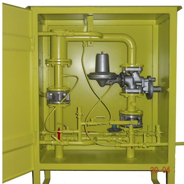
Рисунок 12 – Общий вид газораспределительного пункта ГРПШ-400
